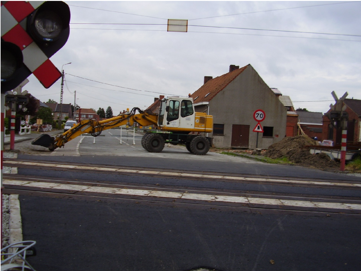
de werken aan de overweg zijn voltooid
