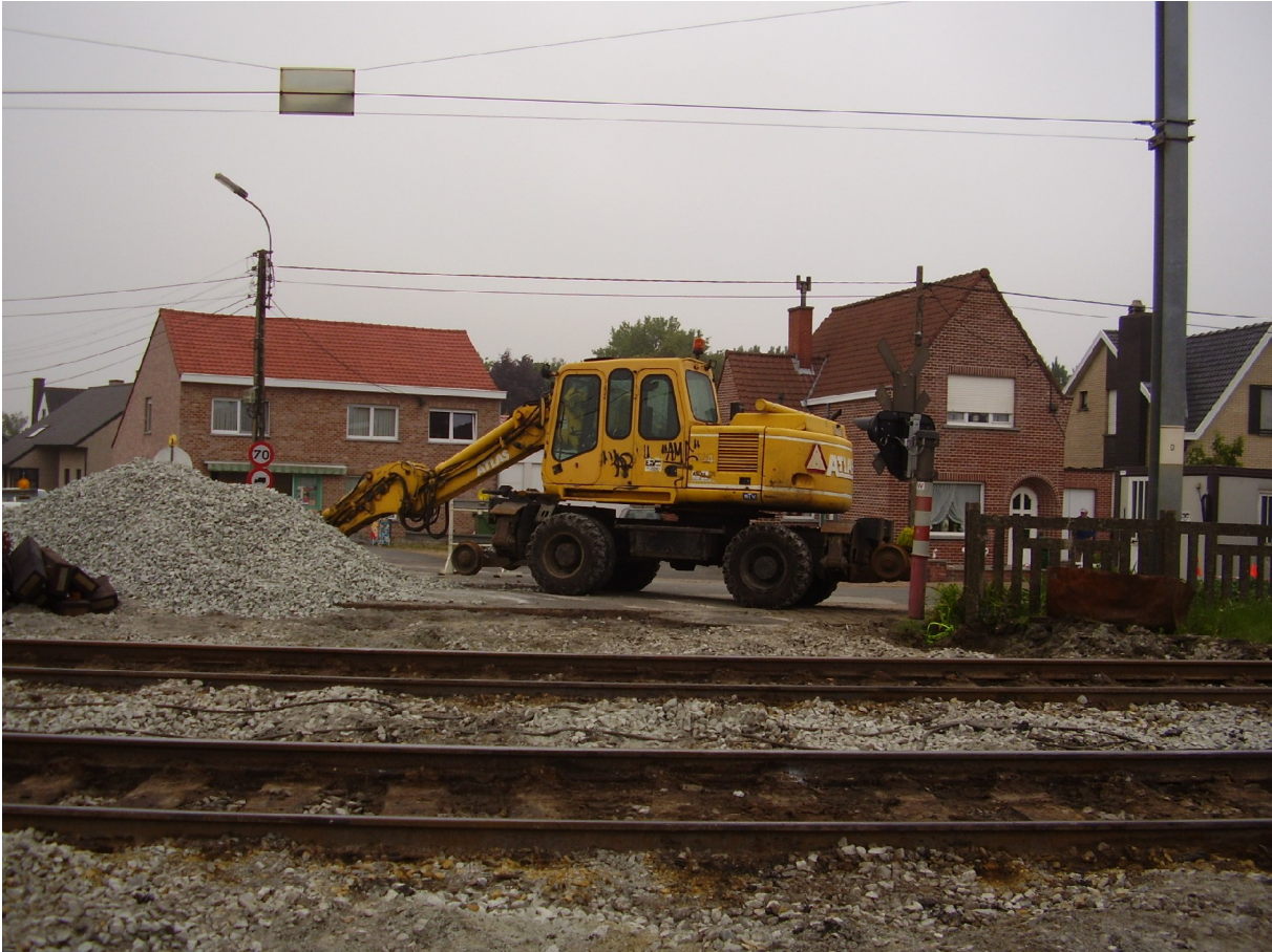
De uitgebroken overweg met een spoorwegkraan van de firma de vuyst
