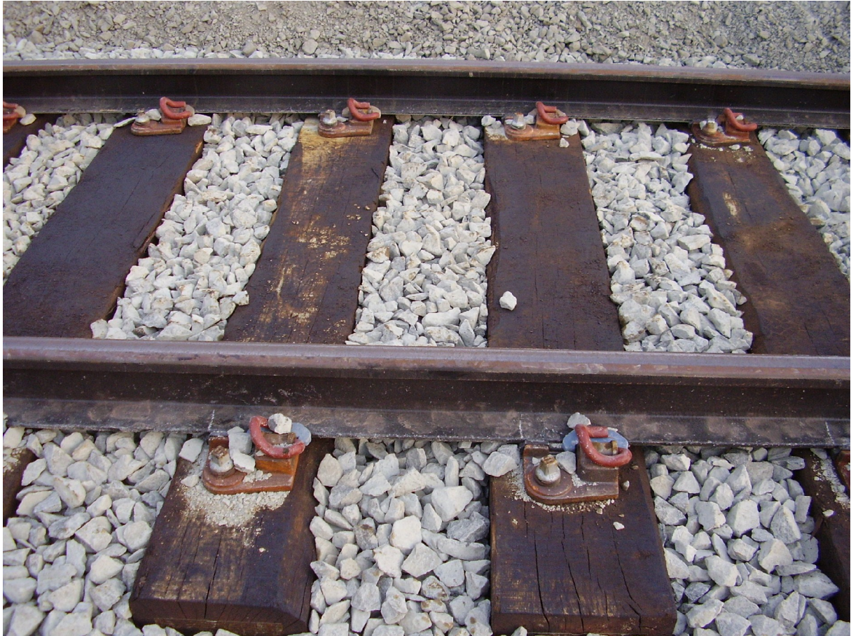
Nieuwe ballast en dwarsslagers zijn al reeds geplaatst
